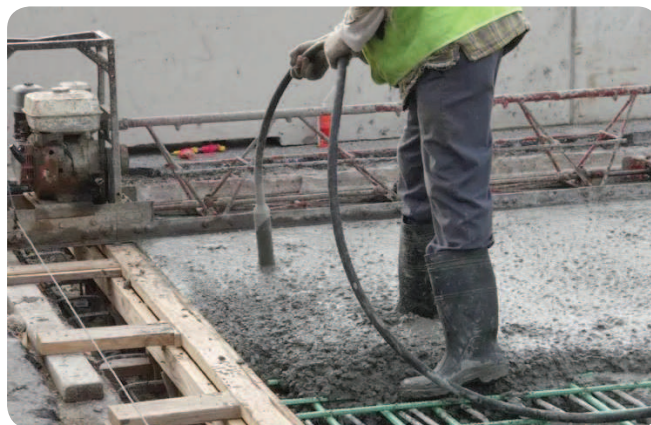
Gambar 2.15 Proses pematatan beton
