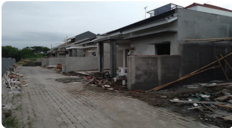
Gambar 1.1 Contoh pekerjaan konstruksi di bidang perumahan Sumber: Winarko (2022)
