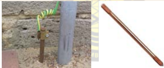
Gambar - Contoh elektrode bumi
