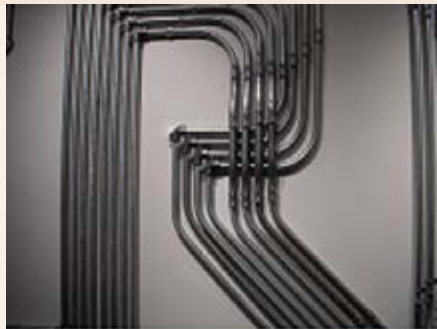
Gambar – Contoh sistem konduit kaku
