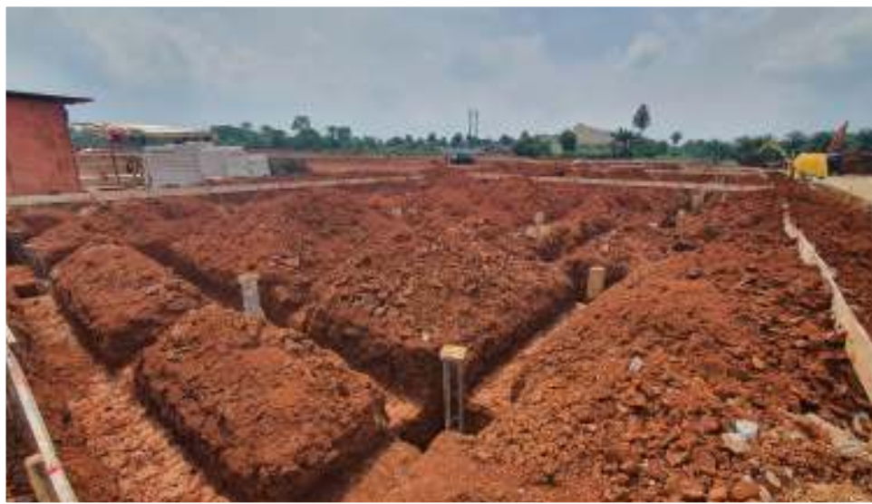
Gambar 1.5 Pekerjaan galian tanah fondasi dengan alat manual.
