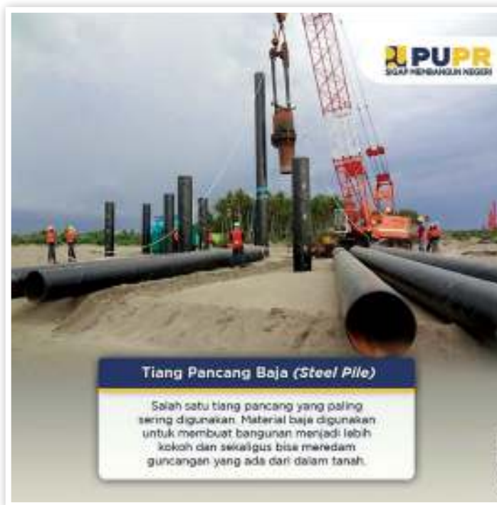
Gambar 5.7 Tiang Pancang dari Baja
