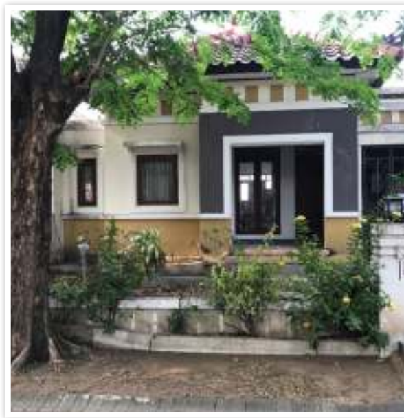
Gambar 5.16 Aplikasi Beton pada Rumah Tinggal
