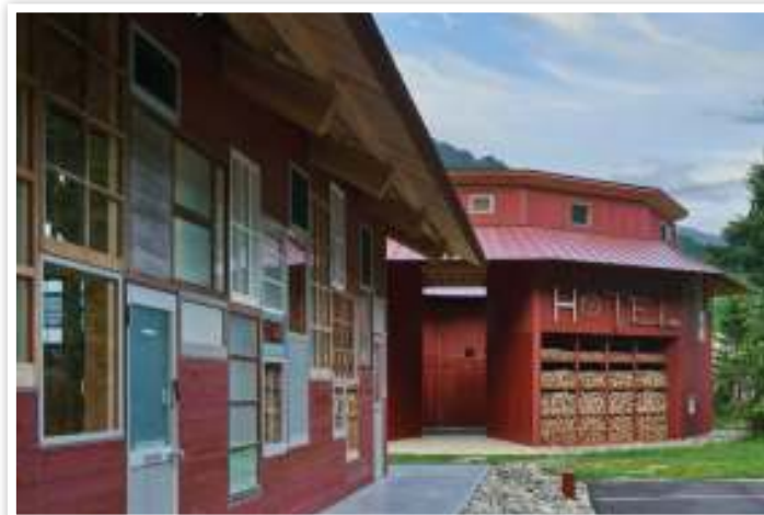
Gambar 6.3 Bangunan Kamikatsu Zero Waste Centre di Jepang.
