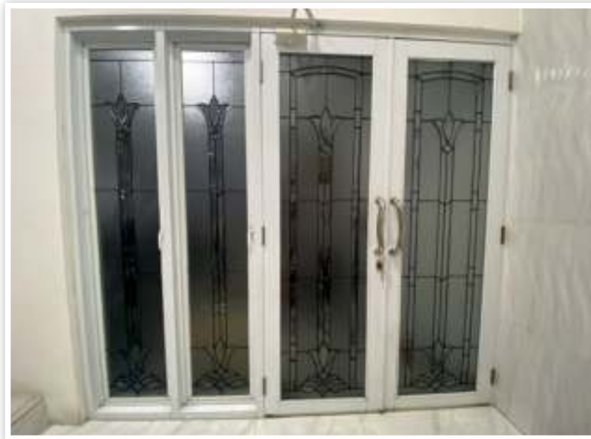
Gambar 1.13 Pekerjaan Pemasangan Pintu dan Jendela
