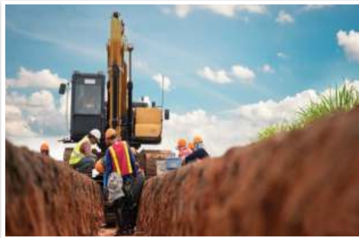
Gambar 1.6 Pekerjaan galian tanah fondasi dengan alat berat konstruksi.
