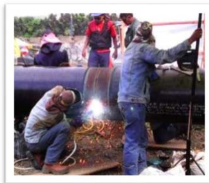
Gambar 1.12 Pemasangan Pipa di atas Tanah
